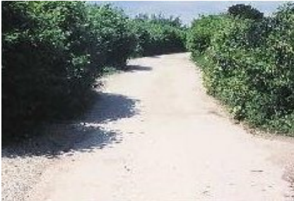
Abb. 5 (links) und 6 (rechts). Temporäre Hauptwege mit wassergebundener Decke. Rechts: Anlage des Wegs auf alten Gleisen.
