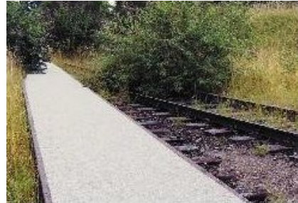
Abb. 5 (links) und 6 (rechts). Temporäre Hauptwege mit wassergebundener Decke. Rechts: Anlage des Wegs auf alten Gleisen.
